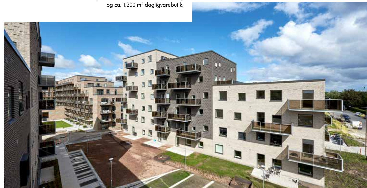
ÅBYEN, AARHUS 265 boliger og Netto i stueetagen. Ejendommen er terrasseret mod syd, hvilket giver en optimal udnyttelse af lys, og udsigt mod Ådalen og kolonihavehusene. 20.000 m² bolig og ca. 1.200 m² dagligvarebutik.
